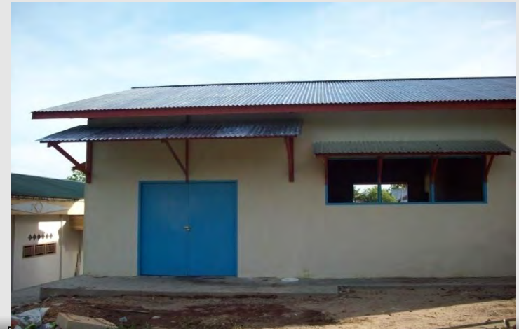
Tahap konstruksi Depo 3R
